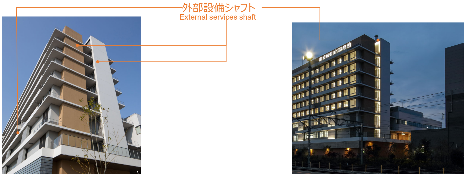
写真-4 外部シャフト外観写真 Photo 4 Photos of external shaft
