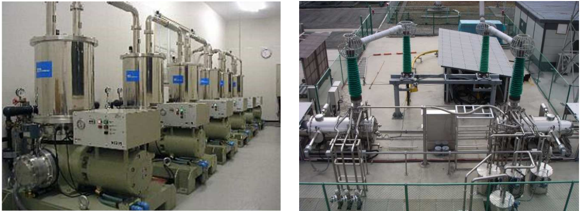
図5 真空断熱管の使用例（トランスファーチューブ）
