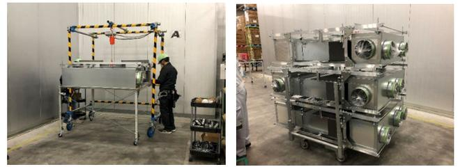
写真 5-2 場外ロジ内での室内機廻りのオフサイトユニット化
