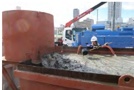
掘さく土のサンプリング
