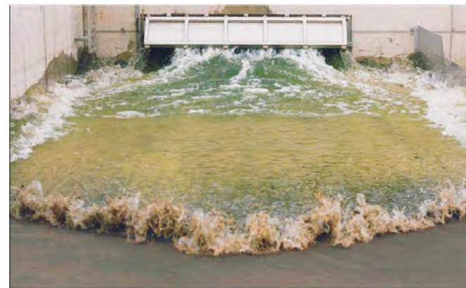
熱交換器洗浄のためのフラッシング装置（引用 11) ）
