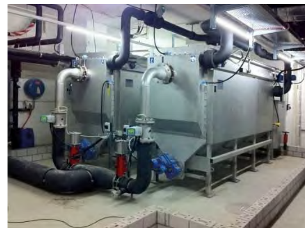
① Abwasserkanal; ② Abwasserschacht mit Siebanlage und Förderpumpe; ③ HUBER Abwasserwärmetauscher RoWin; ④ Wärmepumpe
