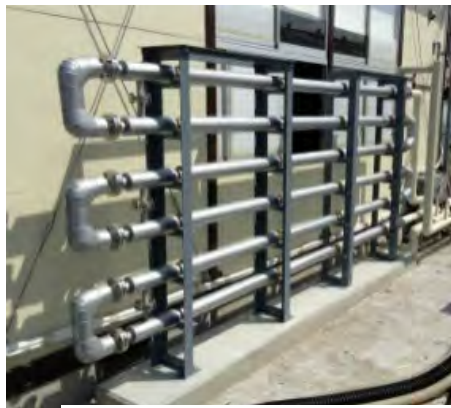
二重管式熱交換器
