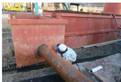
泥水循環配管の接続
