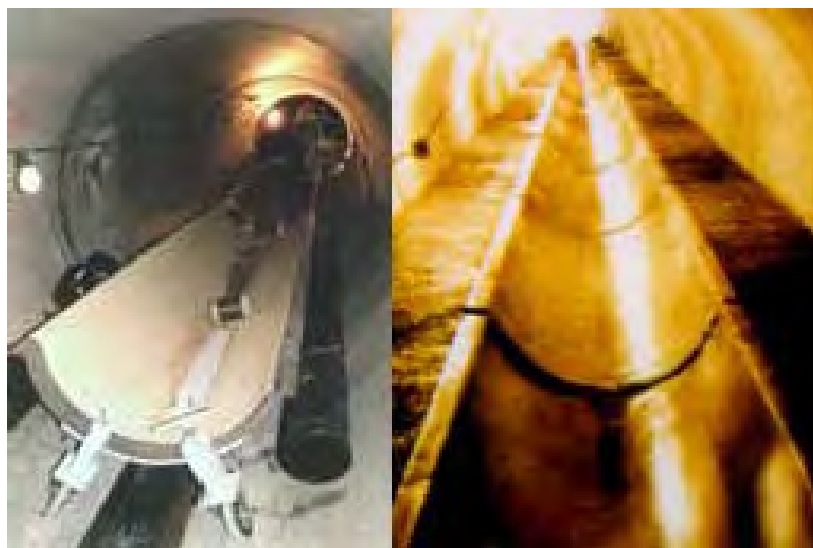
管渠内熱交換器敷設状況 (Wipkingen、スイス)
