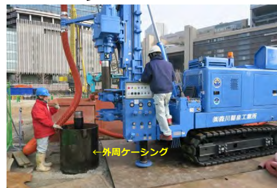
ボーリングマシンの整備
