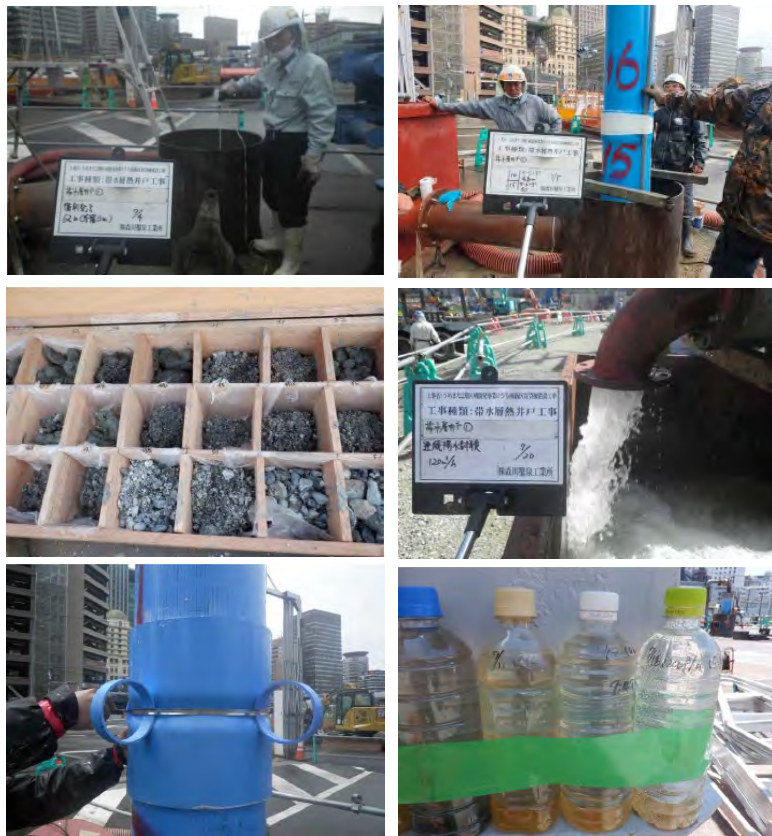
南賃貸棟工事写真
