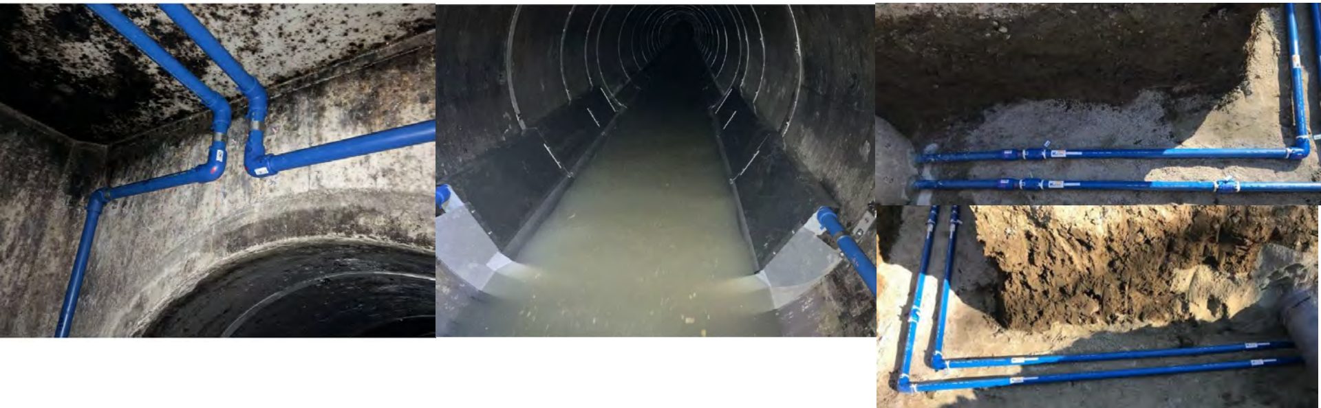
下水熱配管工事写真
