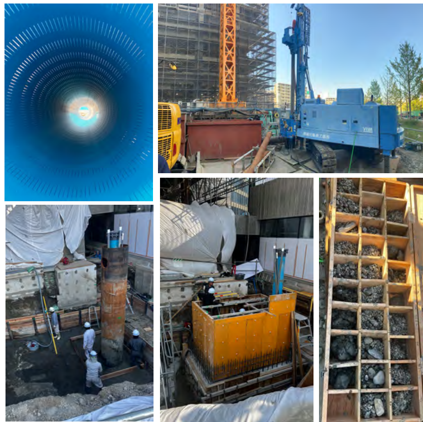
北賃貸棟工事写真
