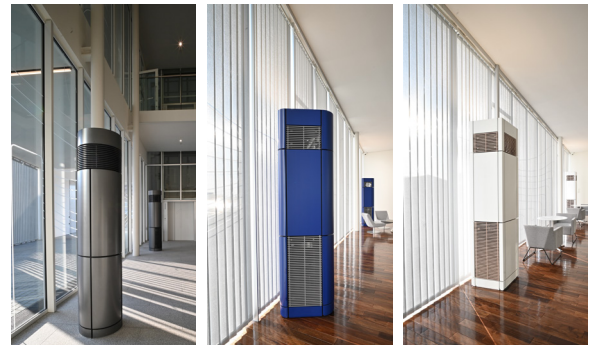
写真-6 各階のポスト型ファンコイルユニット
