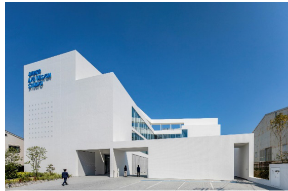
写真-1 建物外観
