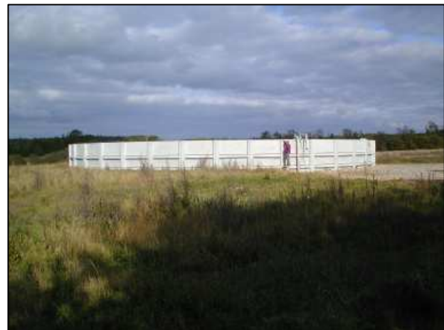
液肥貯蔵タンク (家畜の糞尿をバイオガスとしコジェネ燃料に)
