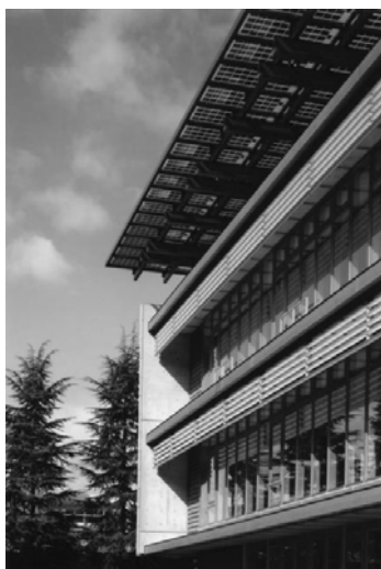
図4 南側ガラス開口・外ルーバー・庇
