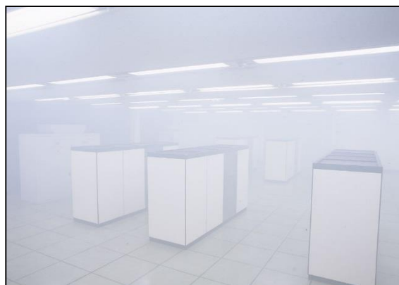
写真2 サーバルームなどの煙状況
