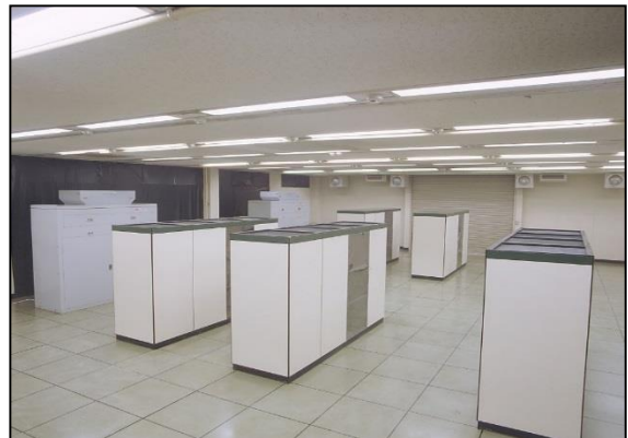
写真3 火災予兆センサ発報時の室内煙状況
