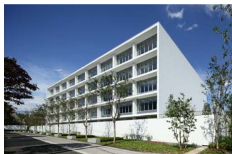
写真1 本館研究棟外観
