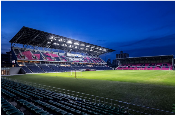
図2 競技用照明のLED化
