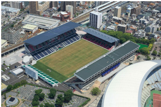
図 4 鳥瞰図 (左奥が雨水集水している西側屋根)
