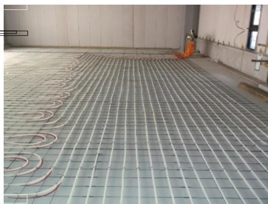
図6 躯体蓄熱架橋ポリエチレン管敷設状況
