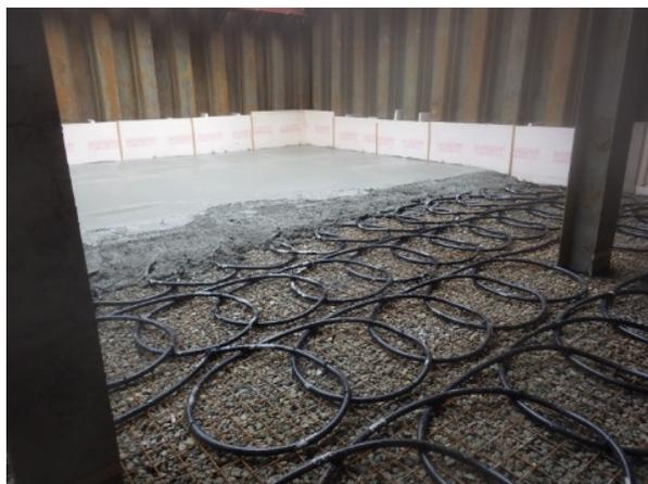
図3 水平コイル型地中熱交換器
