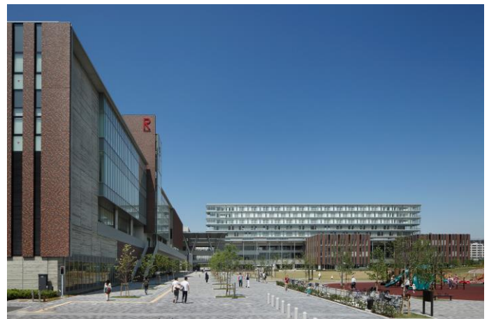
写真-1 建物外観
