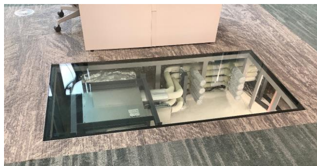
写真 4 VCS 室内ユニットを見せるガラス床
