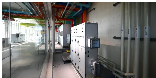
写真2 空調機を見せるガラス張りの機械室
