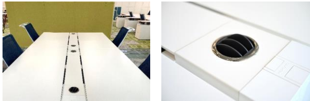
写真7 パーソナル吹出口の配置及び形状
