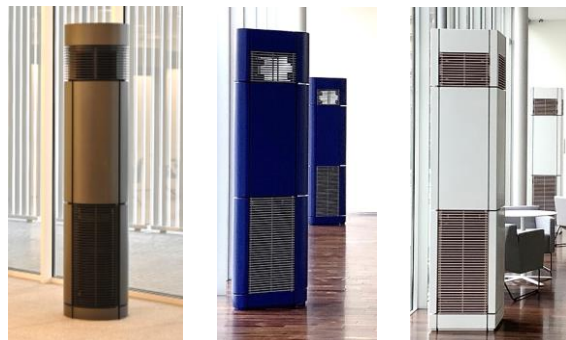
写真 5 各階で形状が異なるポスト型 FCU
