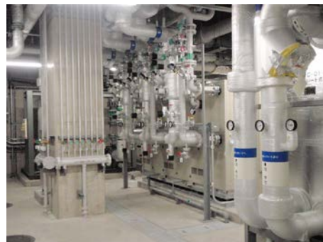
写真-8 熱源機械室
