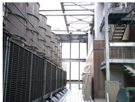
写真-9 屋上冷却塔
