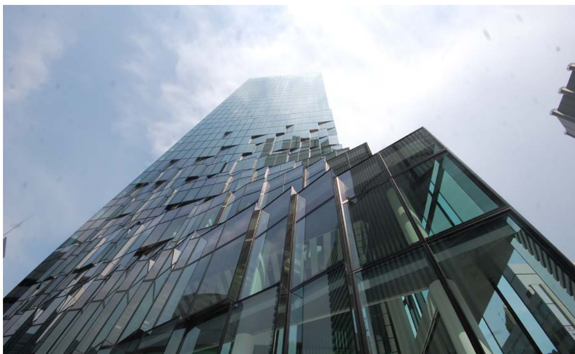
写真－11 西南角より見上げる
