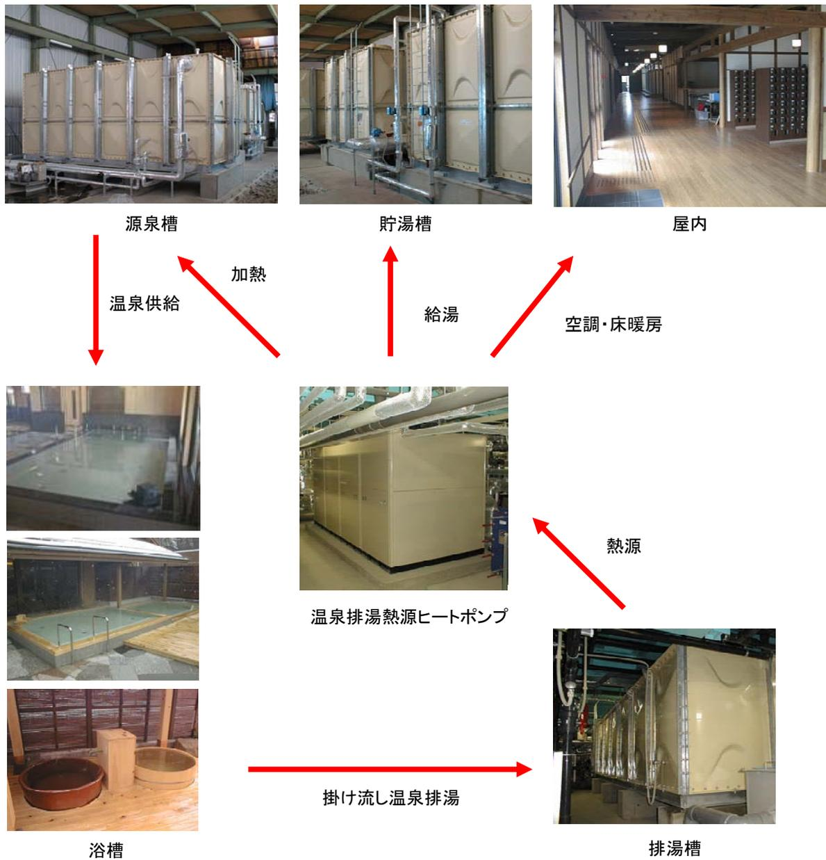
図8 温泉排湯熱源ヒートポンプシステムの例
