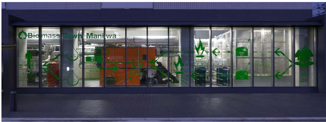
写真4. ガラス張りエネルギー棟外観のサイン
