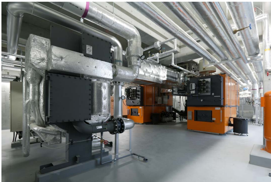
写真3. エネルギー棟内観
