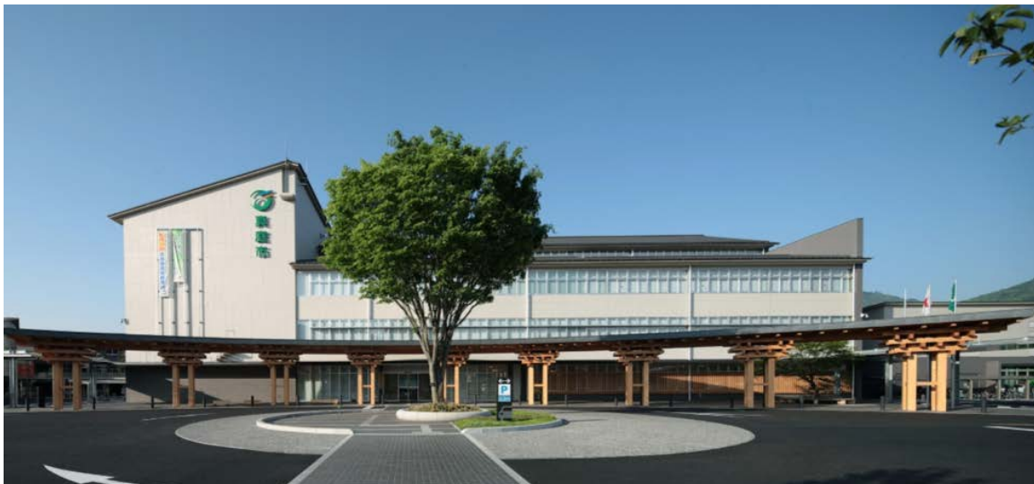
写真1. 正面外観 (真庭回廊と本庁舎)
