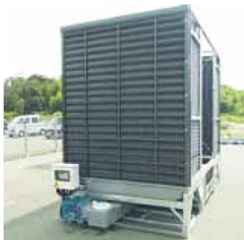
写真－1 冷却塔外観
