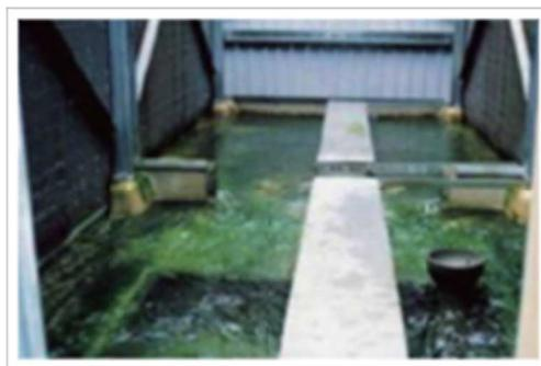
写真-2 冷却塔内部の汚れ
