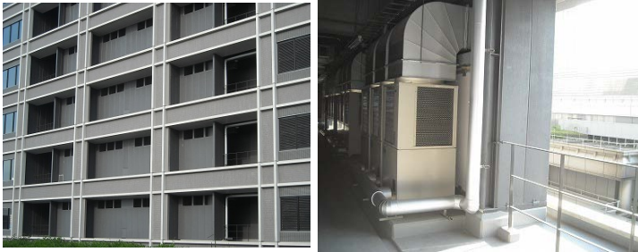
【写真 6.1-1 室外機置場外観】
