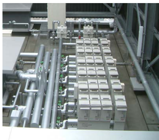
【写真 5.2 連結式ガス瞬間給湯器】
