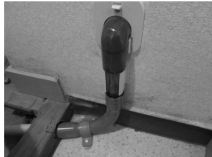
(2) 山越管の施工状況
