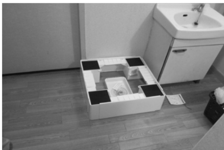
(3) 置き台内部に排水ホース接続ユニットを収納
