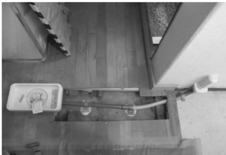
(1) 床下の排水配管の施工状況
