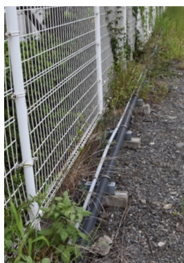
敷地際を転がし配管
