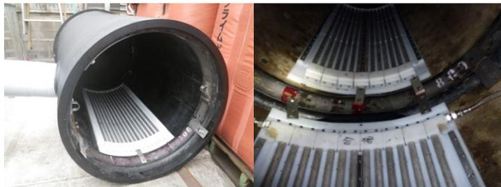
図4 金属製の管渠内設置熱交換器 (引用<sup>5)</sup>)
