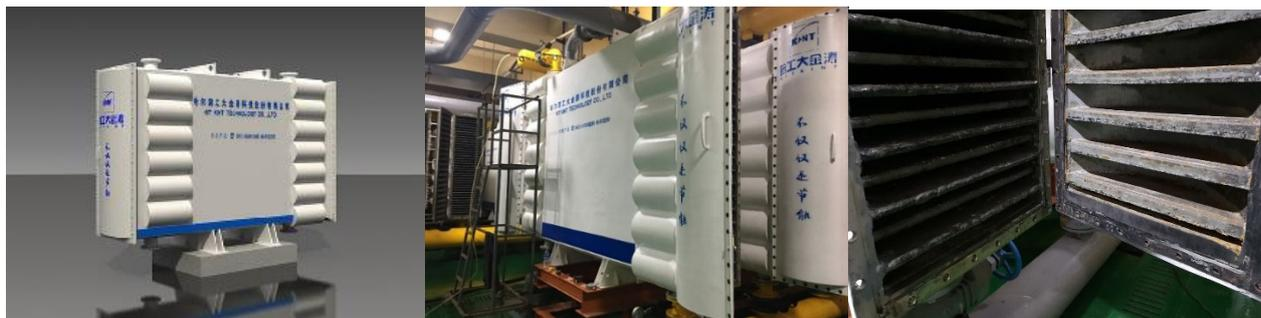
図16 汚水用熱交換器(採熱能力810kW, 右: 外観、引用元, HIT KINT TECHNOLOGY CO. LTD 資料, 中: 定期洗浄後, 扉を開放した状態, 左: 熱交換器伝熱部分)
