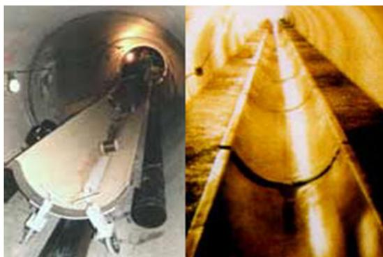
図 13 管渠内熱交換器敷設状況 (Wipkingen、引用<sup>9)</sup>)
