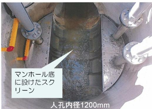
図10 マンホール底部に設けたスプレー洗浄式スクリーン
