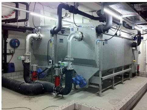
図17 かきとり機能付き熱交換器(引用<sup>11)</sup>) 図18 かきとり機能付き熱交換器の設置状況(引用<sup>12)</sup>)
