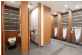
図 1. ブース間仕切りの隙間をなくした例と小便器間仕切りの例
