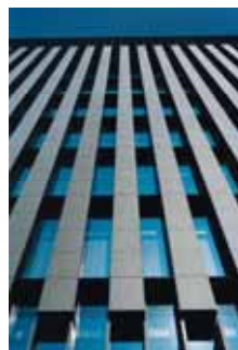
写真-8 外装ルーバーと水平フィン
