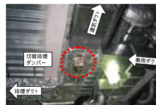
写真-3 切替排煙ダンパーの取付状況
