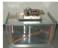
写真-3 切替排煙ダンパーの試作品
