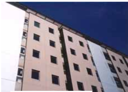
太陽光電池を組み込んだ庇
