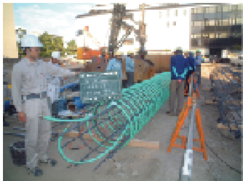
図7 . 施工状況(上: 杭内部、下: 螺旋配管)
