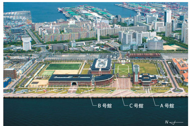
写真 1-1 外観（西側上空より）
