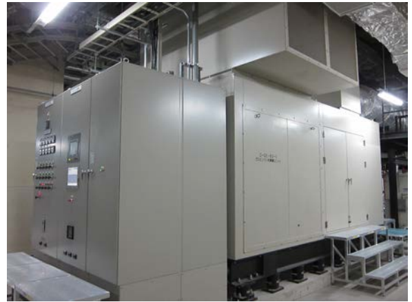
図10 混焼エンジンエンクロージャー
