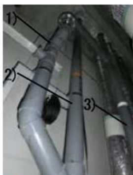
写真2 1)結合通気管 2)排水立て管 3)通気立て管
