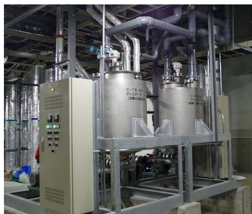
図6 ディスポーザ集合配管システム
