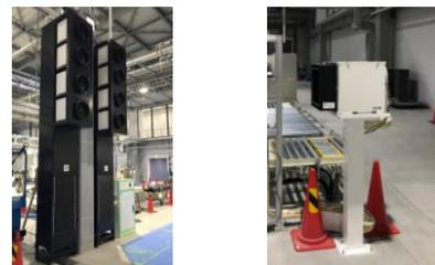
写真2 マルチキューブエアコン (左:アンビエント、右:タスク)
