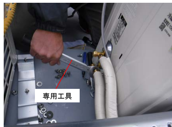
図 10 アルミ冷媒管接続作業
