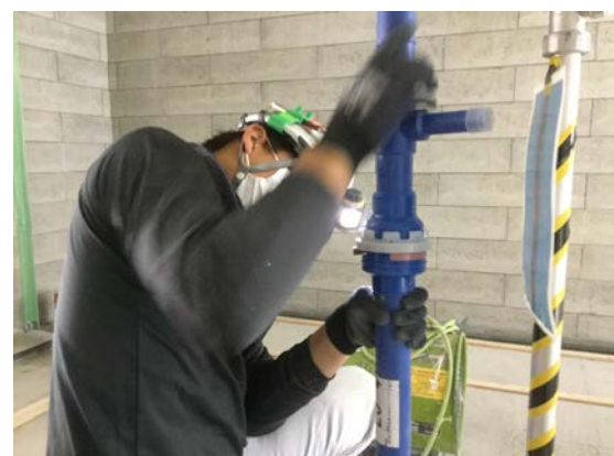
図 11 融着レスプレファブ配管システム接続作業
