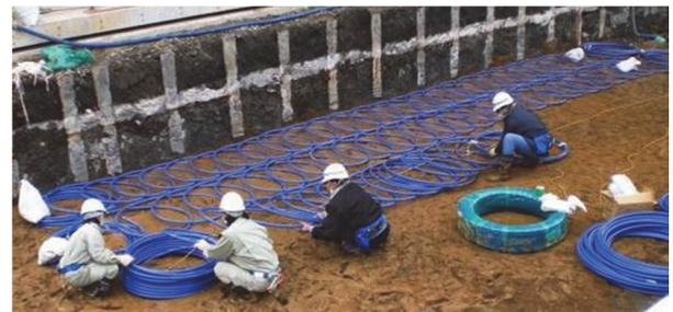
写真-2 水平埋設による地中熱利用(探熱側施工中)
