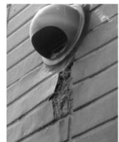
図2 表面塗膜の裏で凍結し剥離した外装の例
