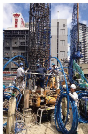
図 14：地中熱交換杭施工
