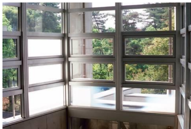
写真 1 サーマトロピックガラスの施工例 18)
