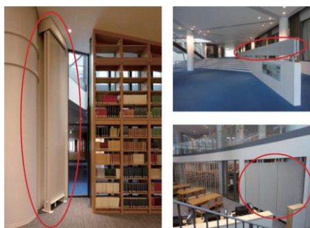
【写真5 井水熱源利用輻射パネル】
