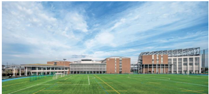
【写真1 建物全景】
