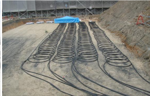
【写真 7 スリンキー式地中熱コイル】
