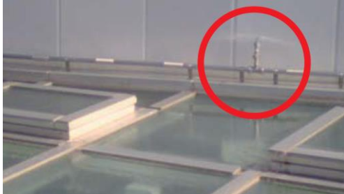
【写真8 トップライト散水】
