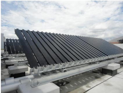
【写真 6 ソルエアヒートポンプ外観】
