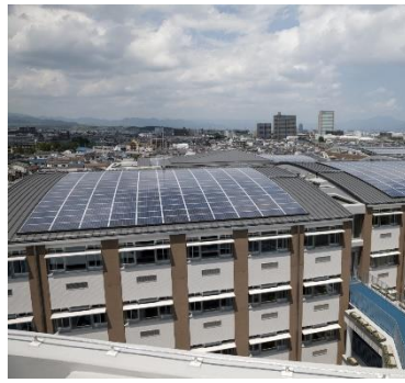
【写真9 太陽光パネル】
