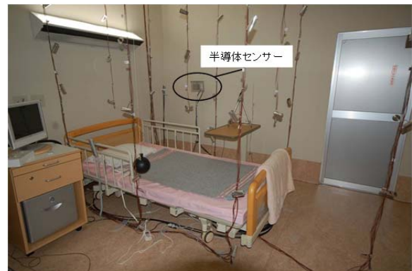
写真2 4床病室ハーフカットモデル内観 (廊下側)
